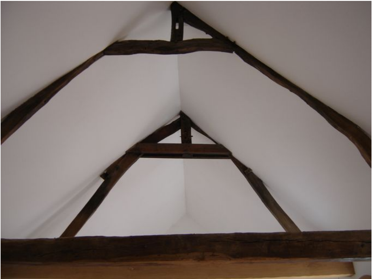
Vue de la charpente de l'ancienne grange.
