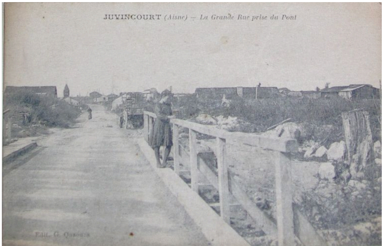
Vue de la rue principale pendant la reconstruction du village (coll. part).
