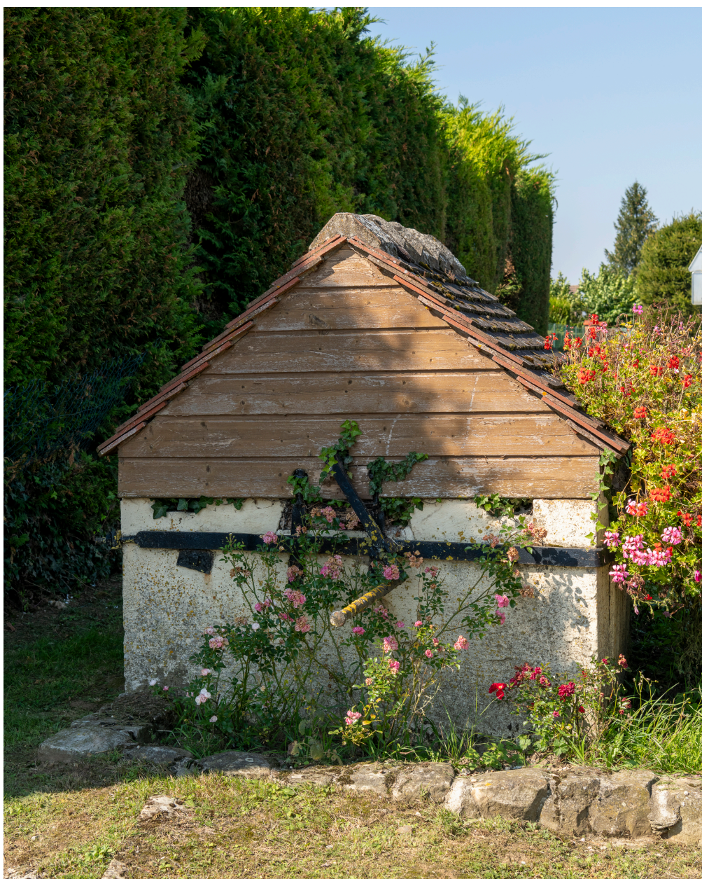
Puits à Évauchaux, rue principale.
