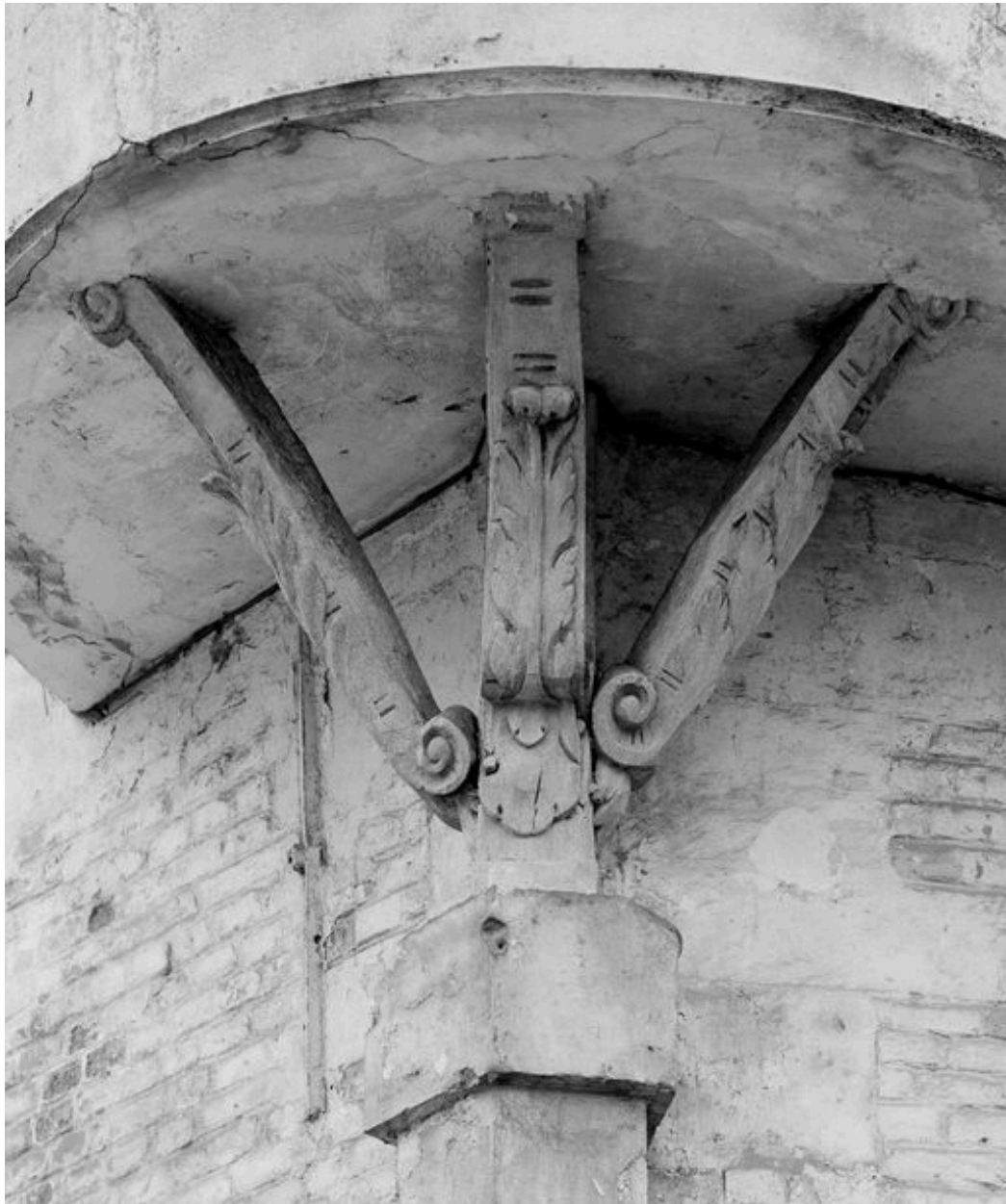
Détail des consoles de l'échauguette.
