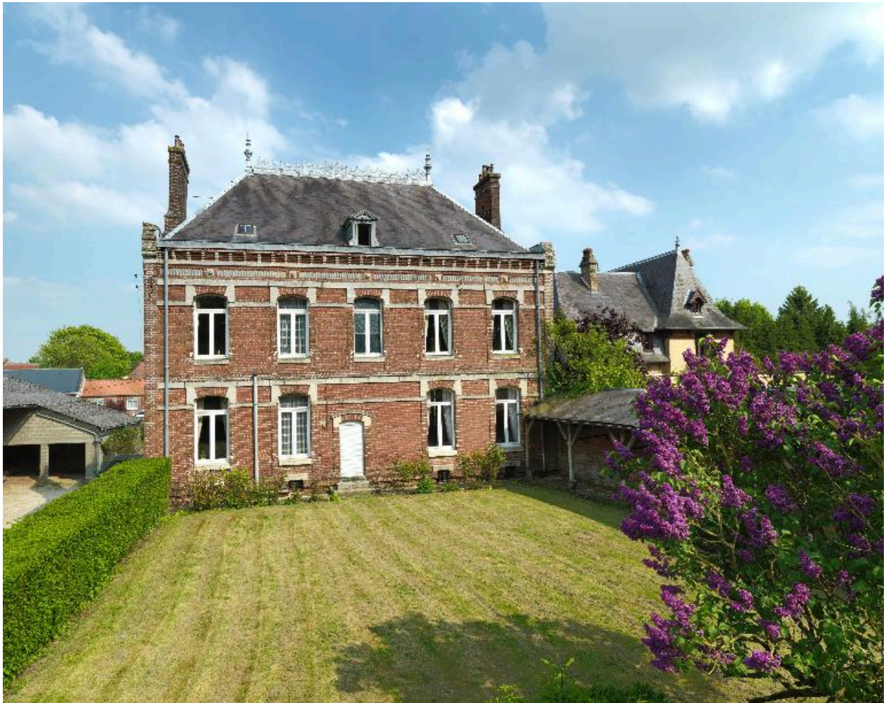
Façade postérieure, vue d'ensemble.
