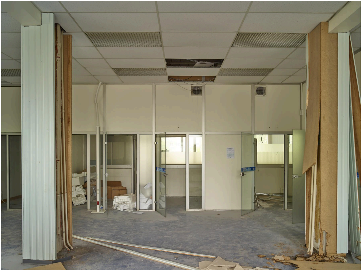
Rez-de-chaussée, hall d'accueil du public de la CPAM.
