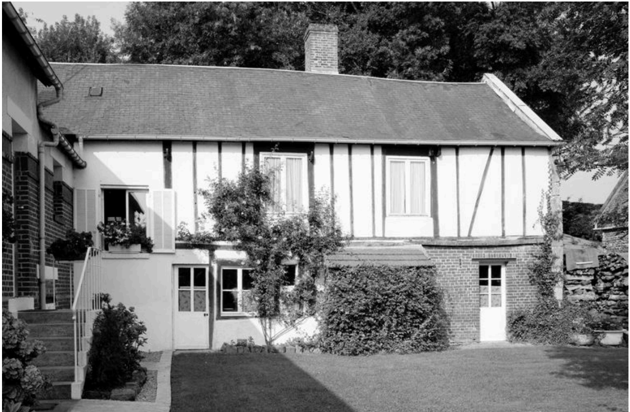
Moulin transformé en logement : élévation sur cour.
