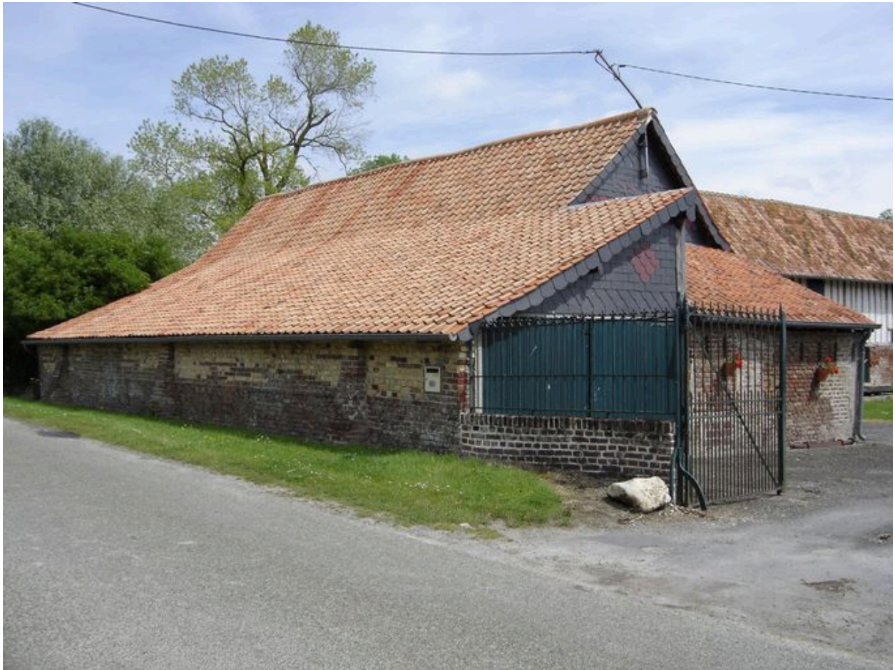
Vue postérieure depuis la cour.
