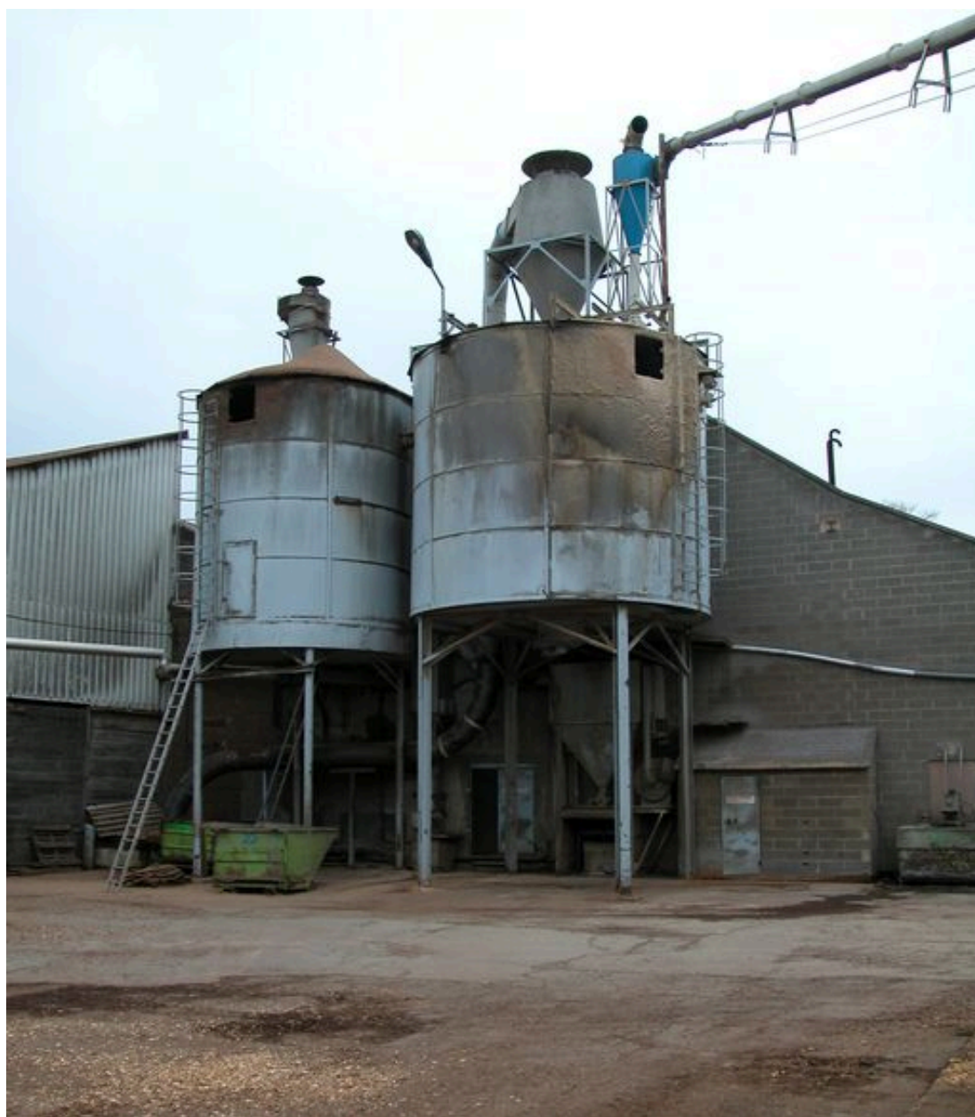
Réservoirs à sciures destinés à la chaufferie.
