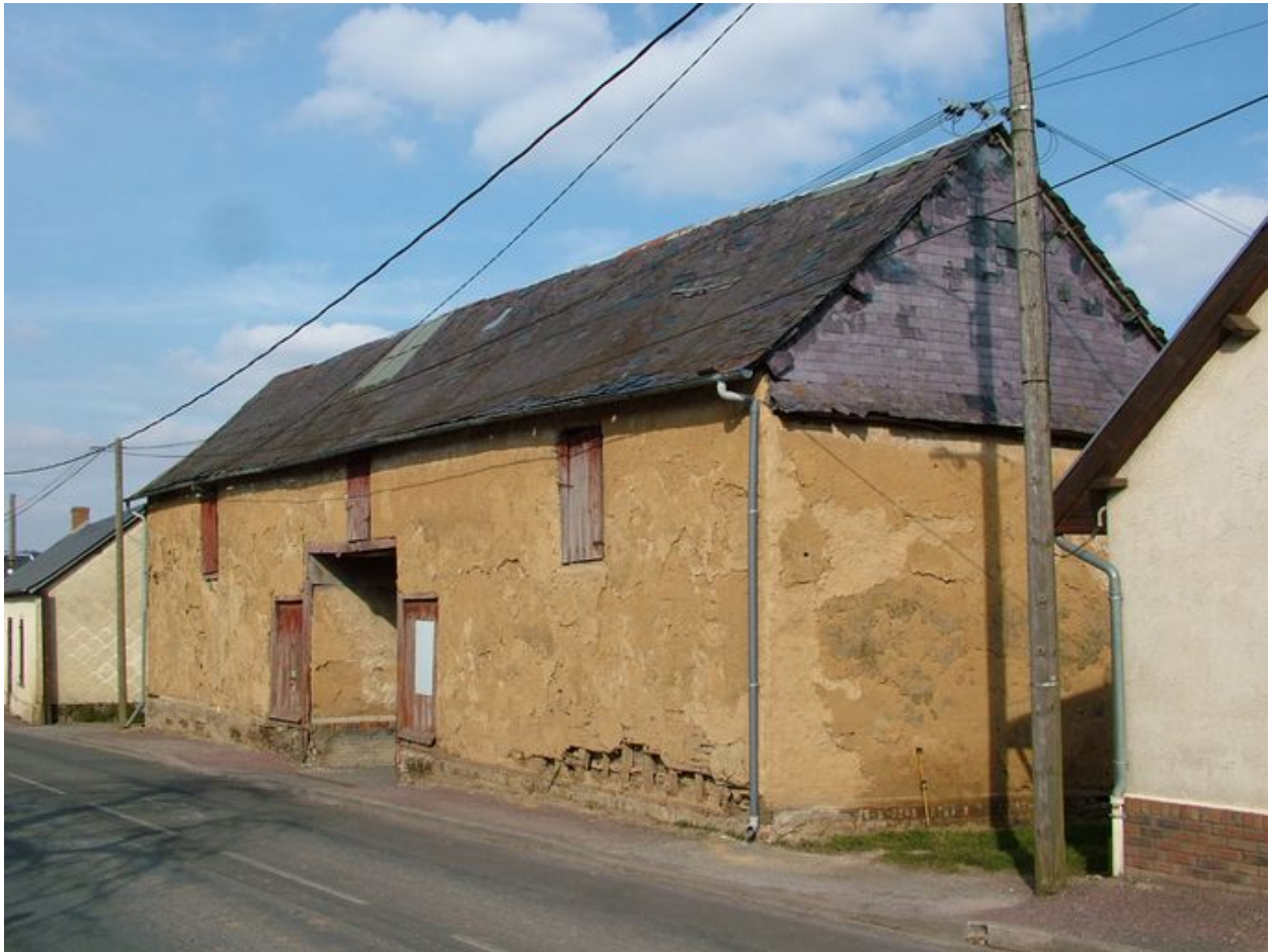
Havernas, grange en torchis de l'ancienne ferme, 5 rue d'Amiens, 19e siècle.
