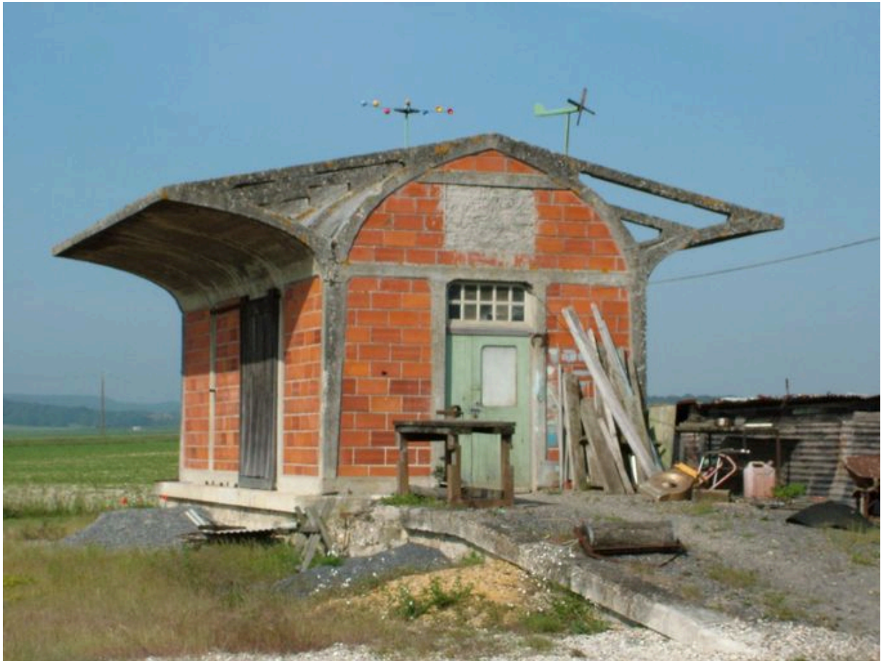
Vue du bâtiment de stockage.
