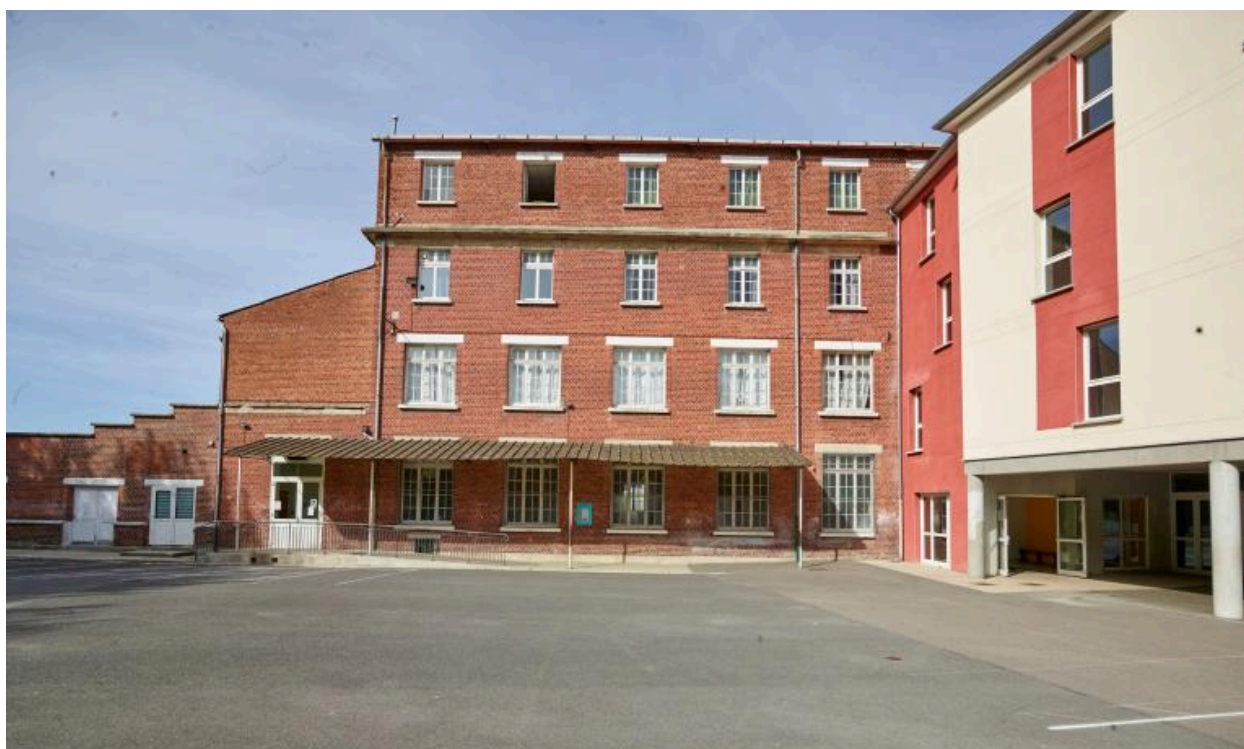
Vue de la cour et des façades arrières.
