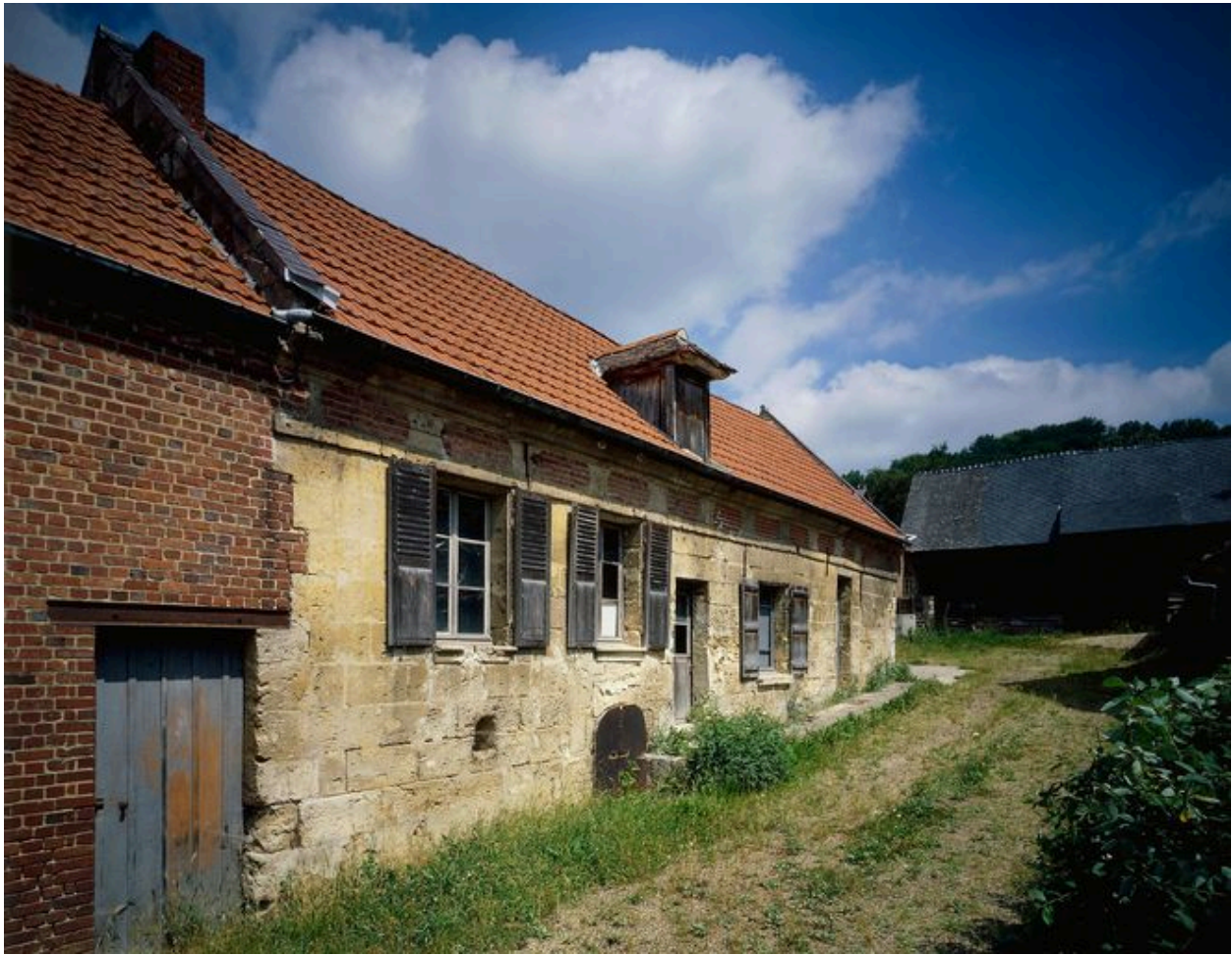
Logis. Elévation antérieure.
