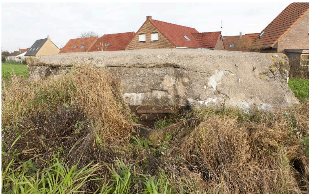
Vue frontale, vers le nord-est. Au milieu, l'observatoire cuirassé (endommagé)
