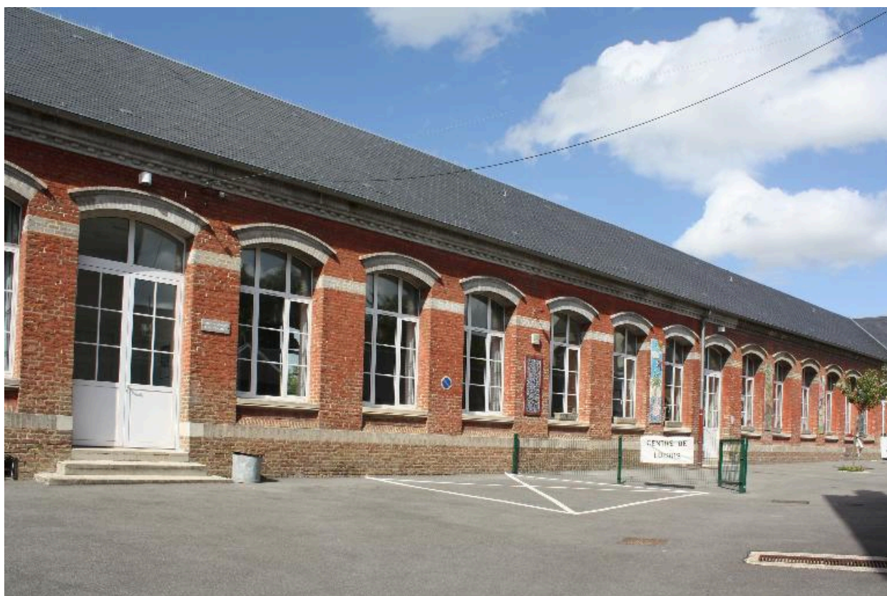
Façade sur cour.
