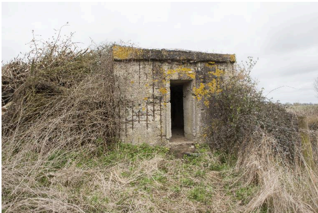
Entrée sur le pignon sud-est
