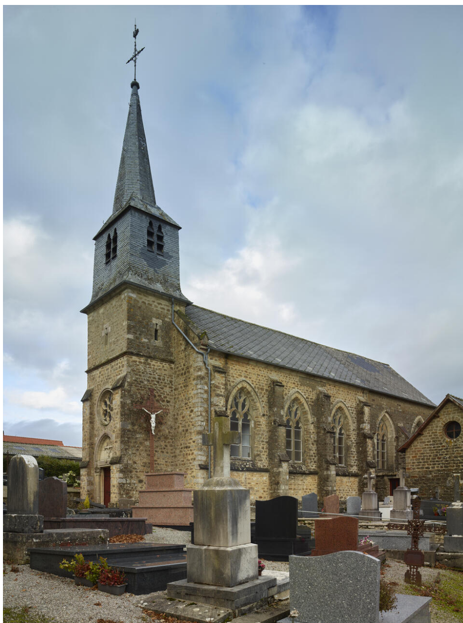
Vue générale depuis le sud-ouest.
