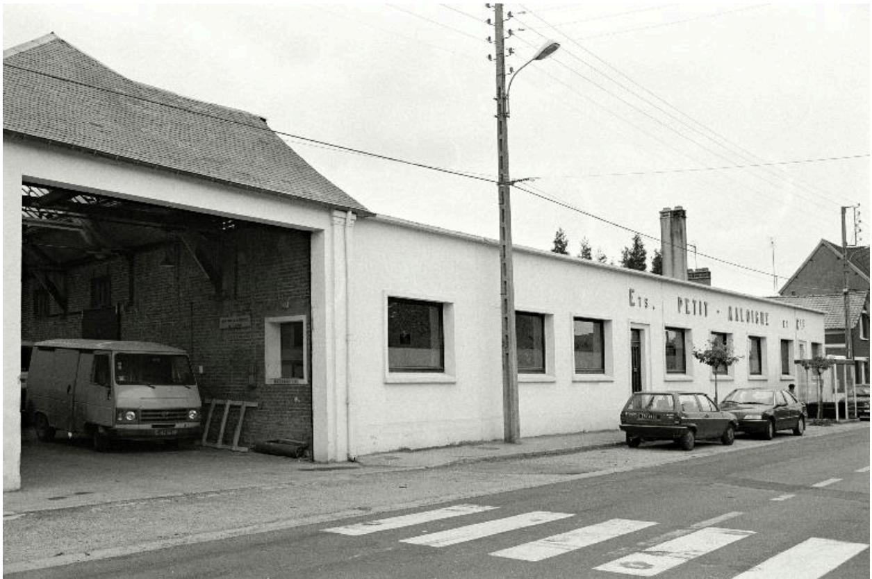
Vue extérieure depuis la rue Jean-Jaurès, en 1990.
