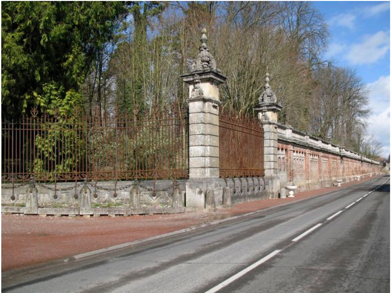
Mur de clôture.
