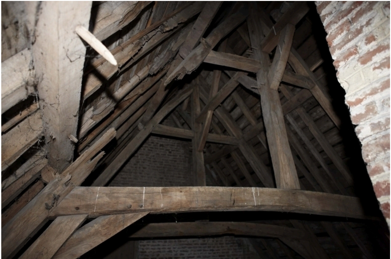
Détail de la charpente du logis.
