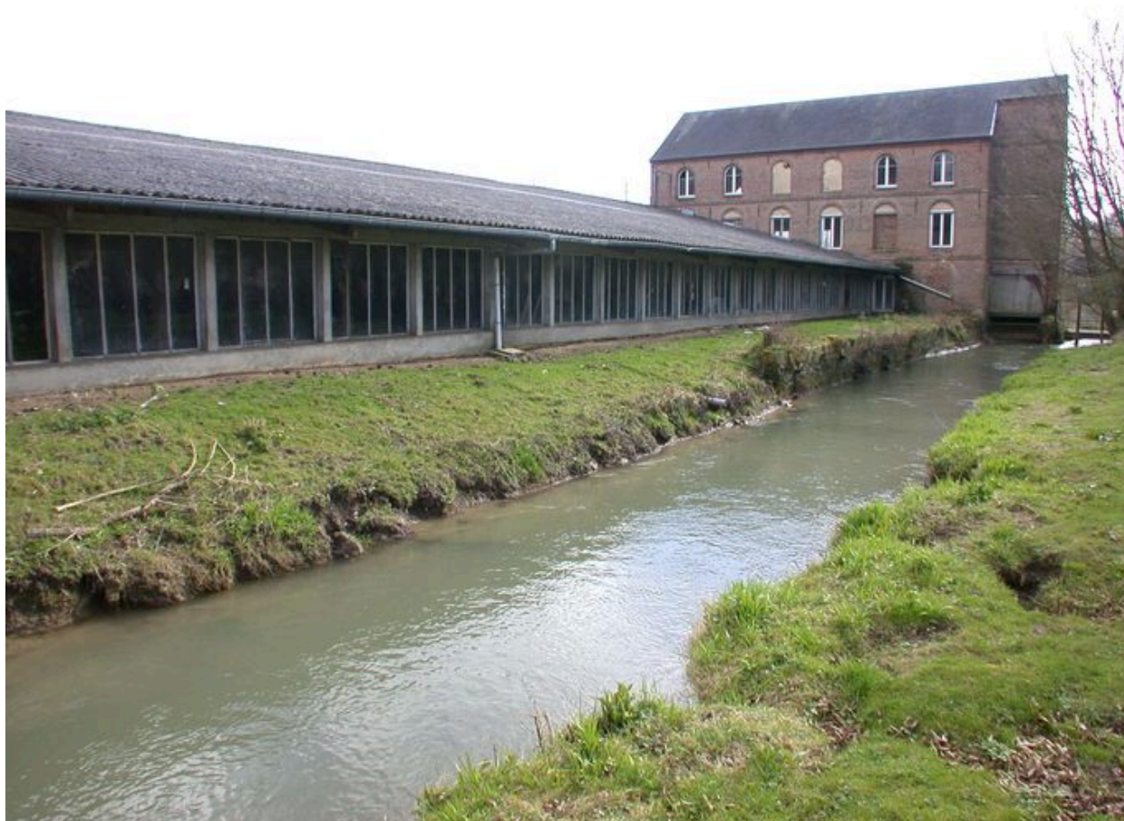
Vue d'ensemble postérieure.
