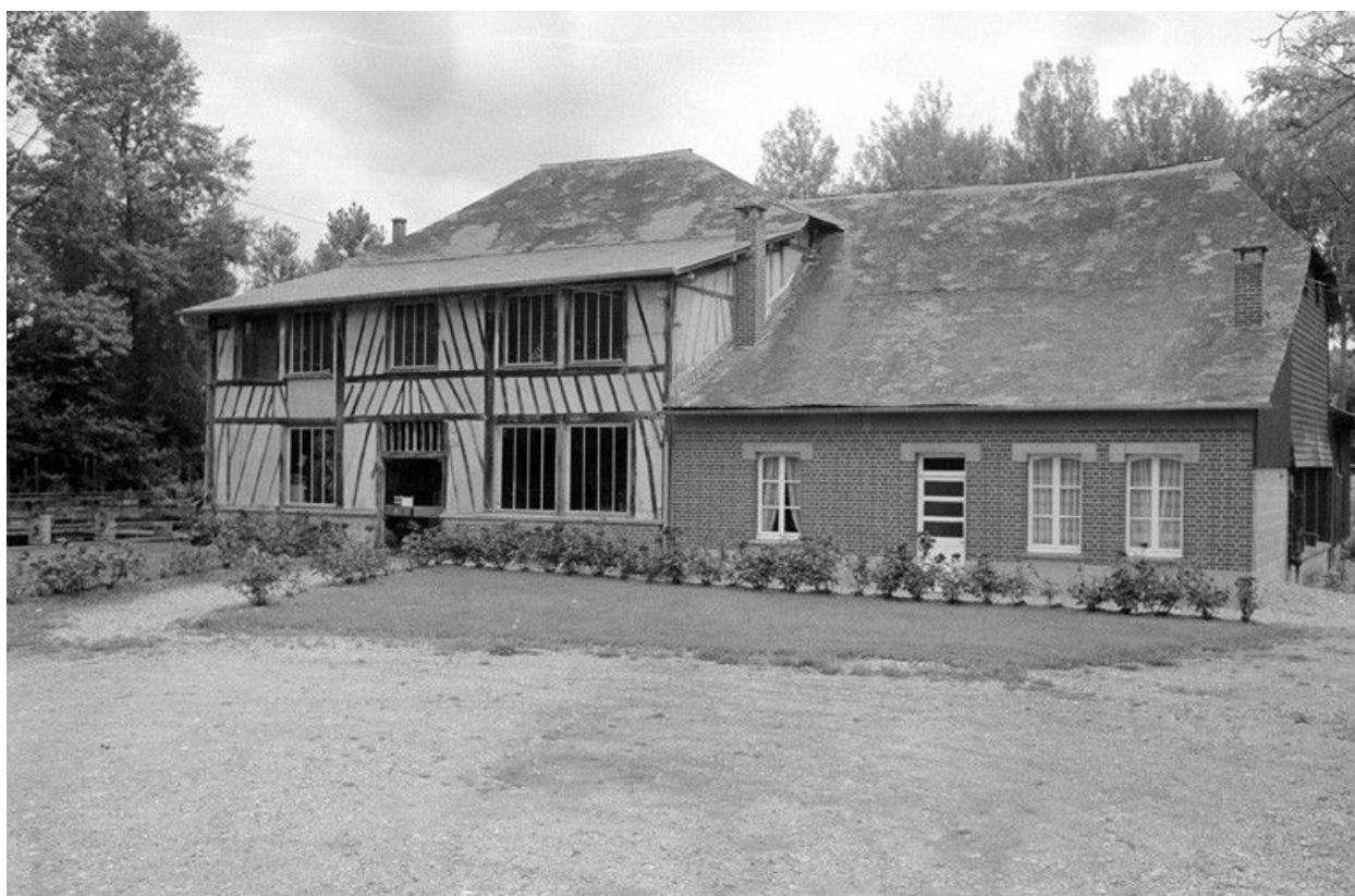
Atelier de fabrication, élévation antérieure.
