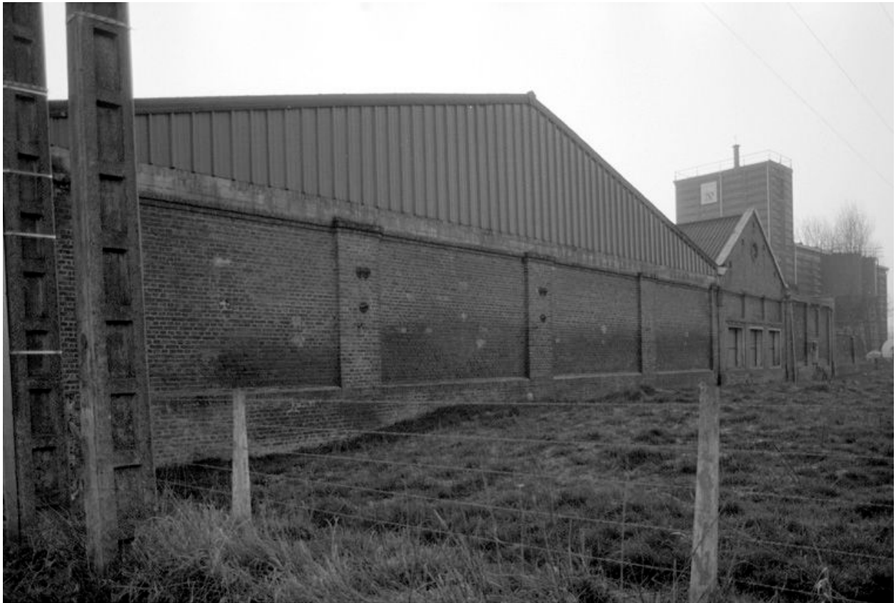
Atelier de fabrication, flanc nord.
