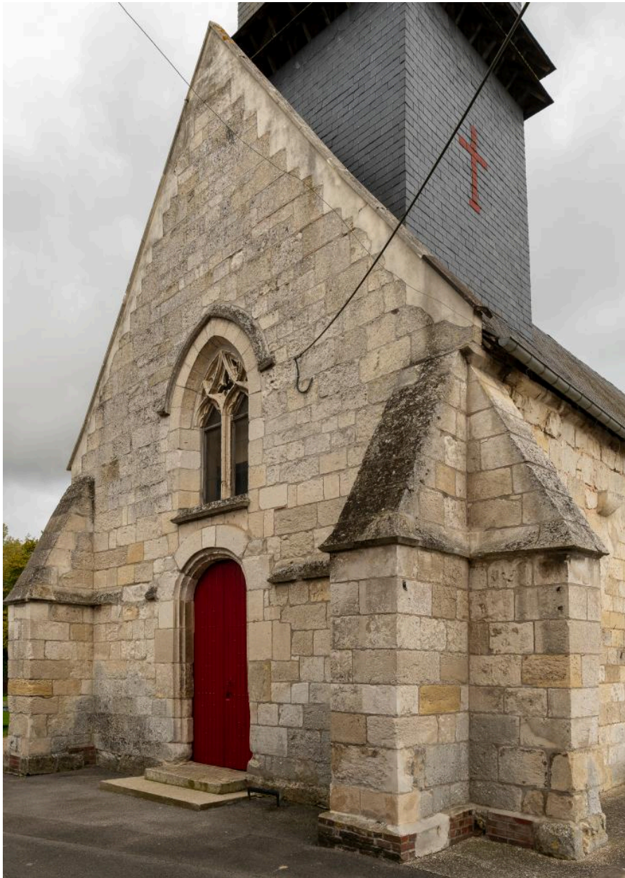
Vue de la façade occidentale.
