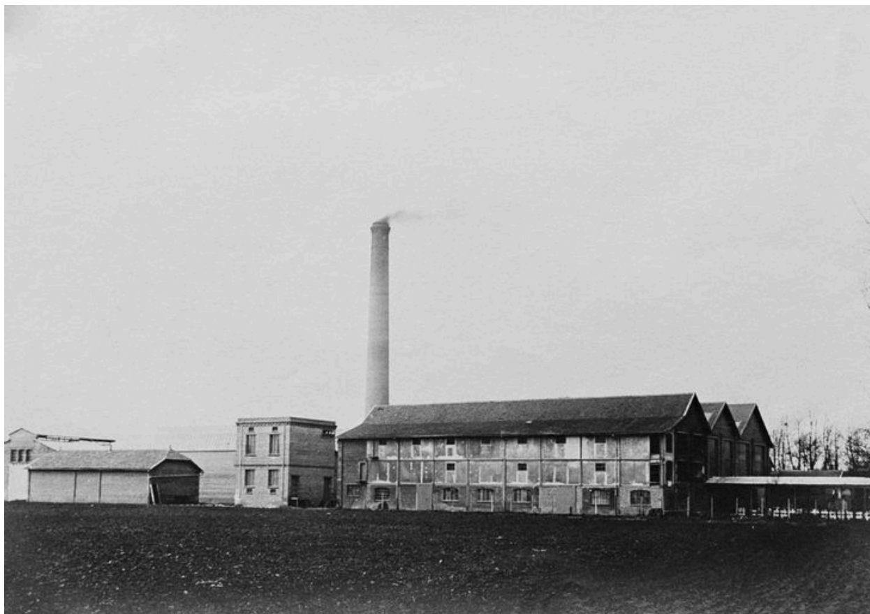
Vue générale de l'usine de colle, vers 1900 (AP).
