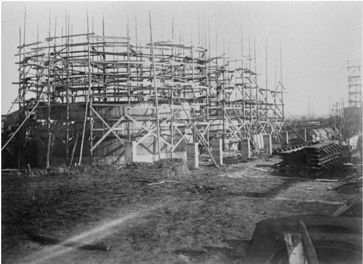
Les cheminées de l'usine en cours de construction (AC Thourotte).
