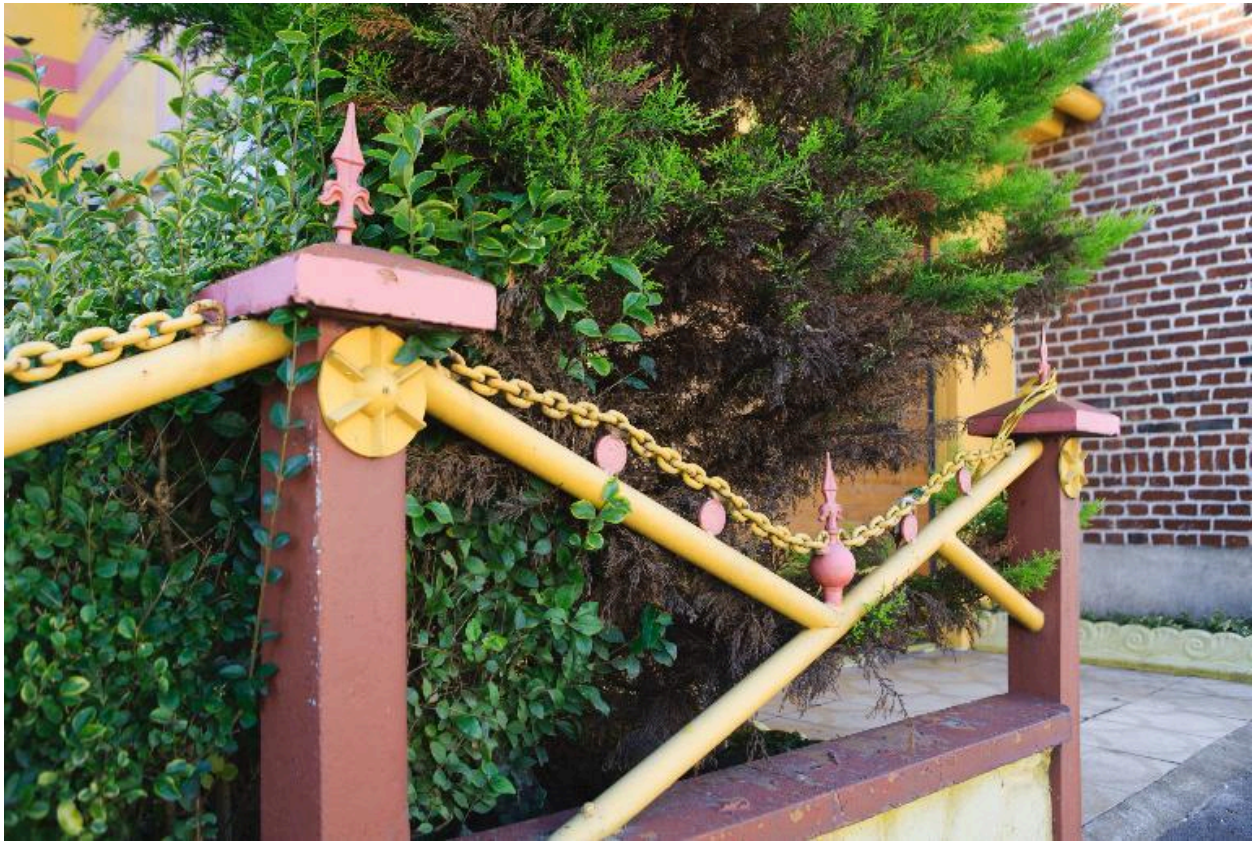
Façade sur rue, détail de la clôture.
