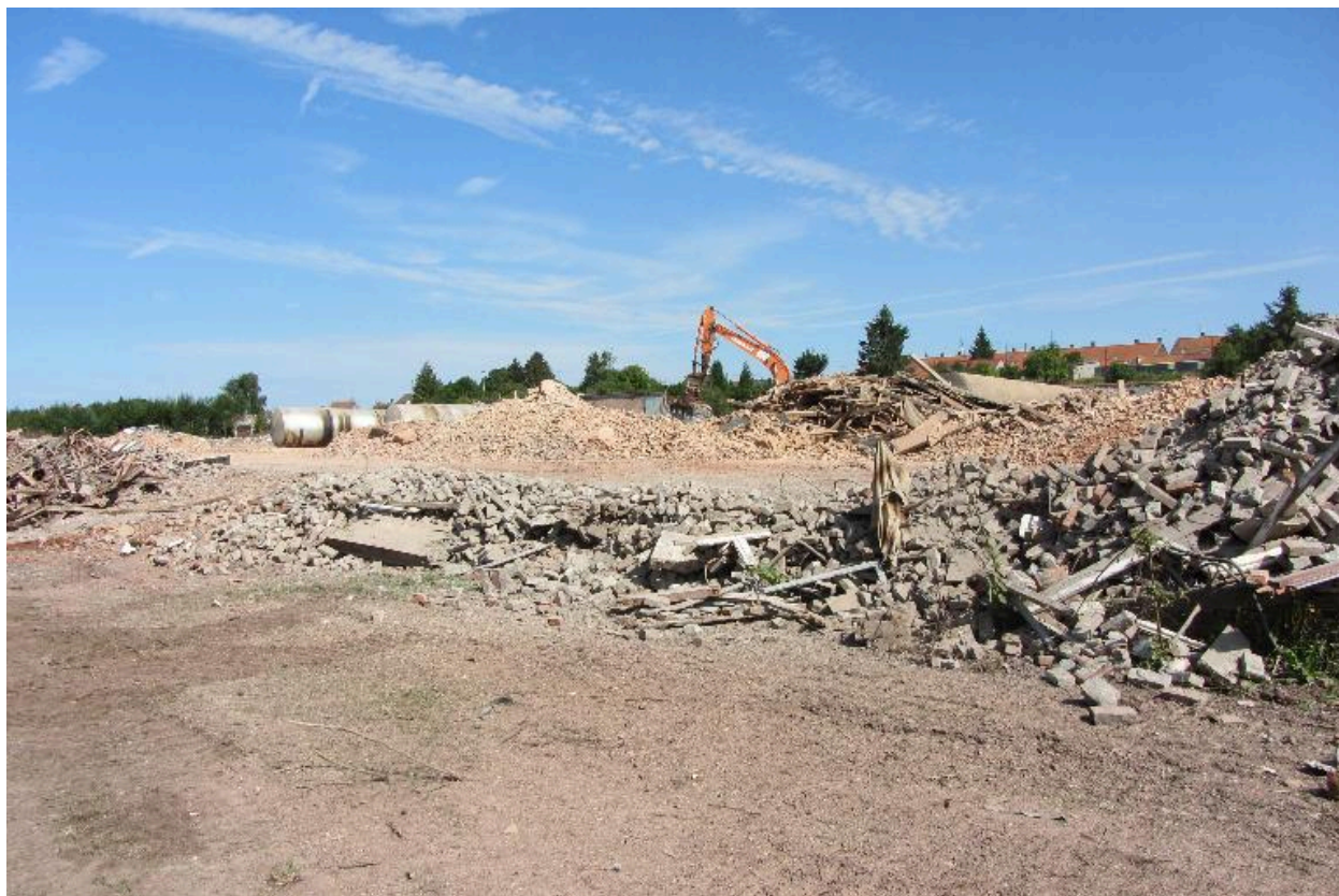
Les ateliers de tissage en cours de démolition, état juillet 2012.
