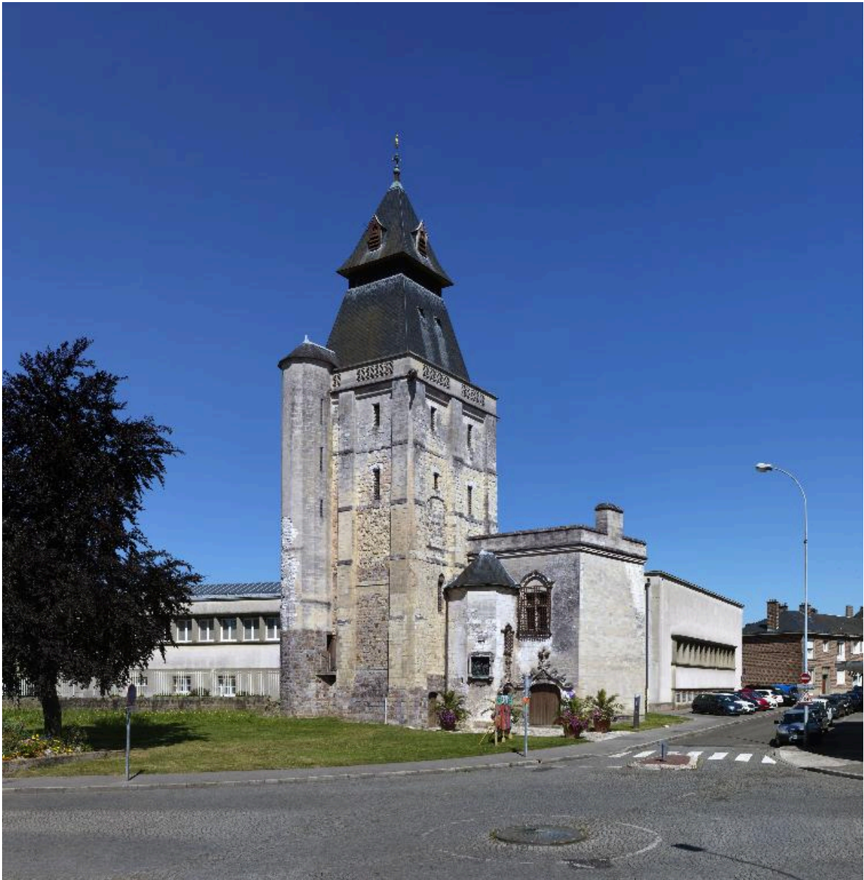
Vue générale du beffroi.
