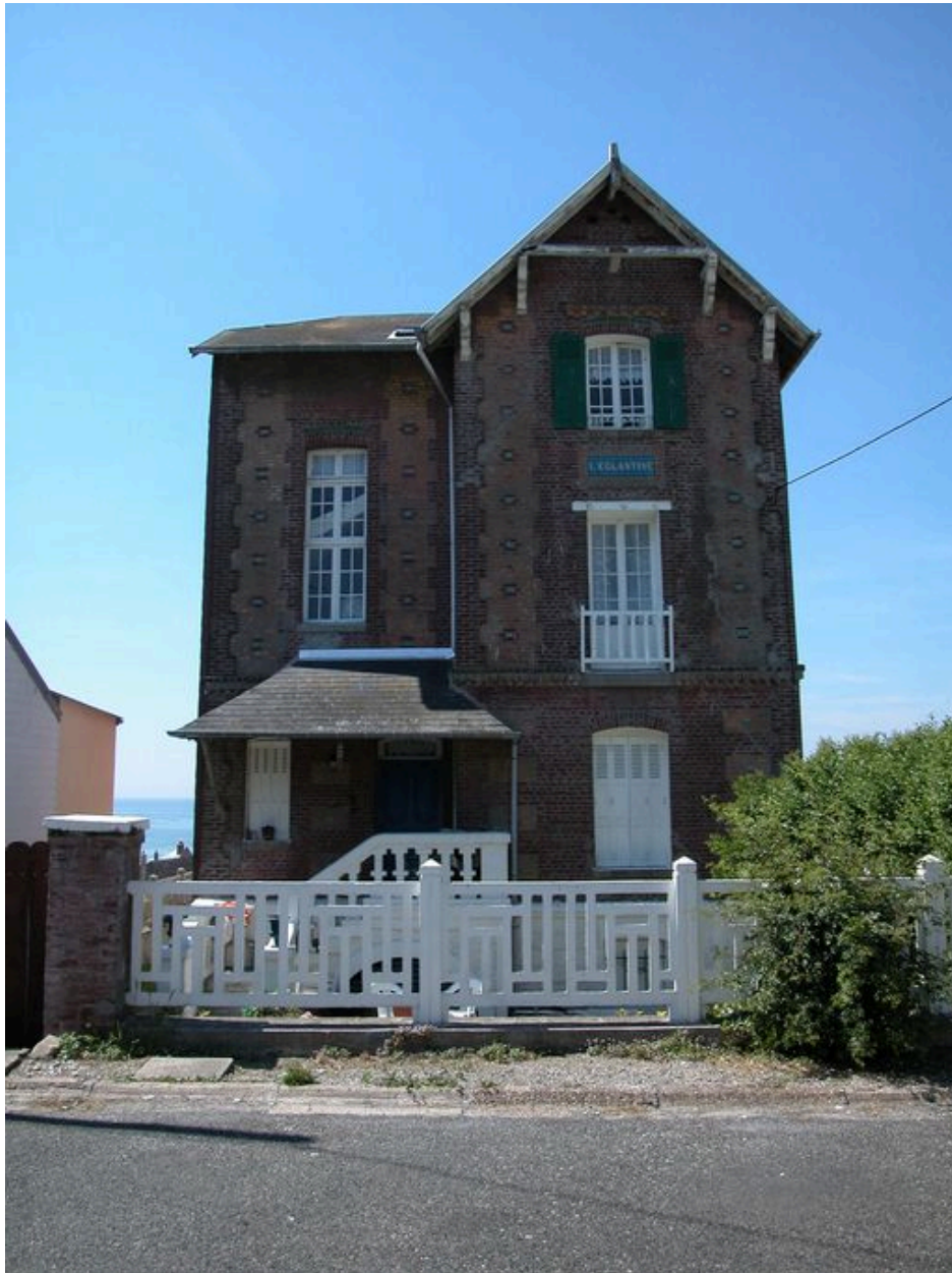
Façade d'entrée (sud-est).
