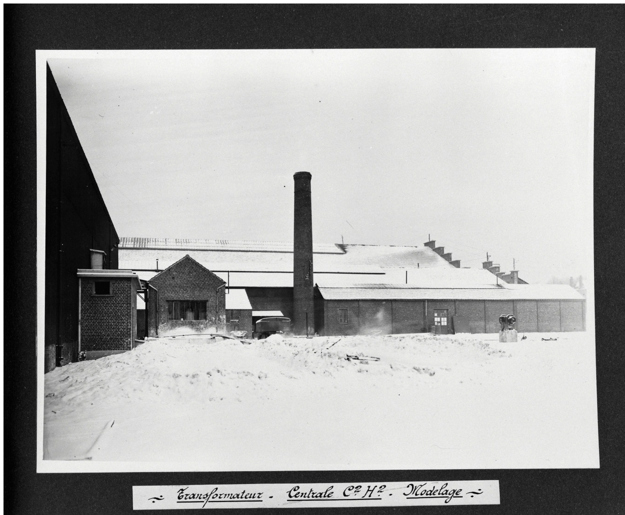
Transformateur, centrale de production de gaz acétylène et atelier de modelage, 16 février 1940. Photographe inconnu (coll. part., archives Cerec).
