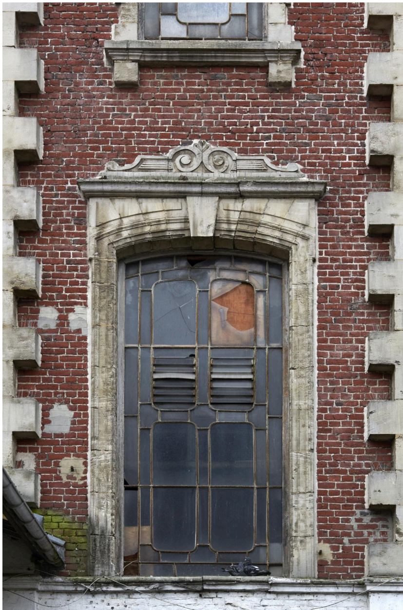
Bâtiment intérieur sur cour, détail fenêtre, fronton décoratif.
