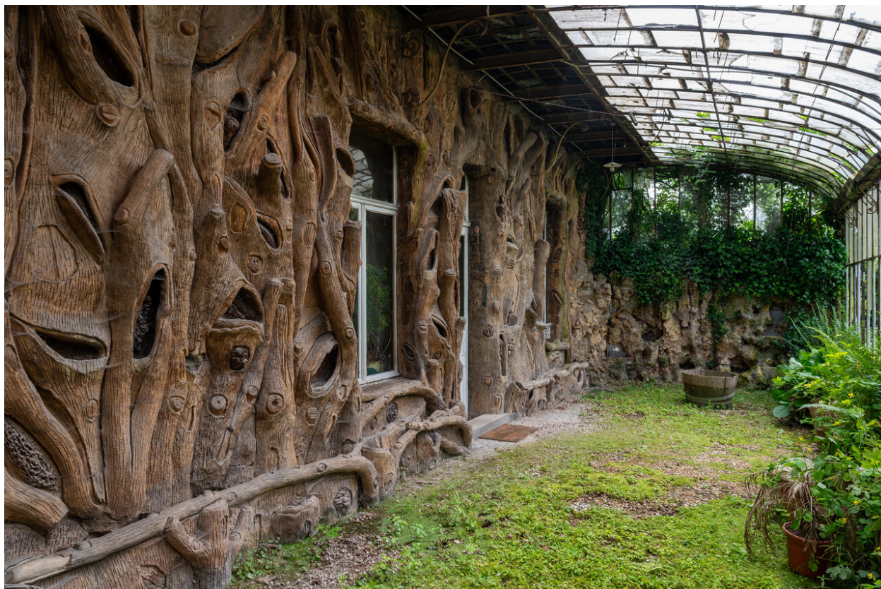
Intérieur du jardin d'hiver et du mur en ciment faux bois.
