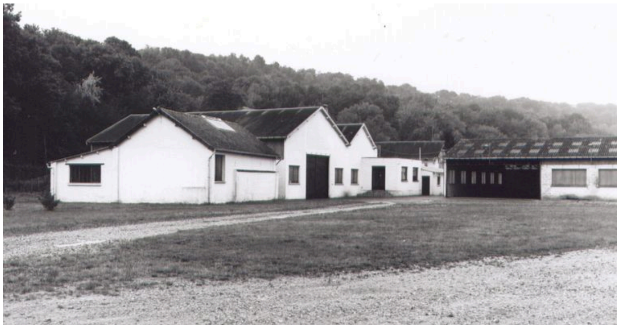
Les ateliers de fabrication et les entrepôts.
