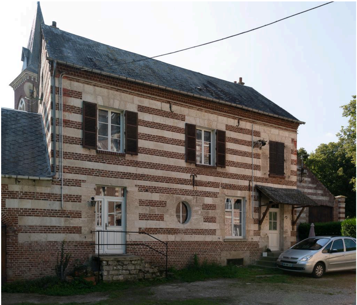
Ancien logement du responsable de ferme vu depuis le nord.
