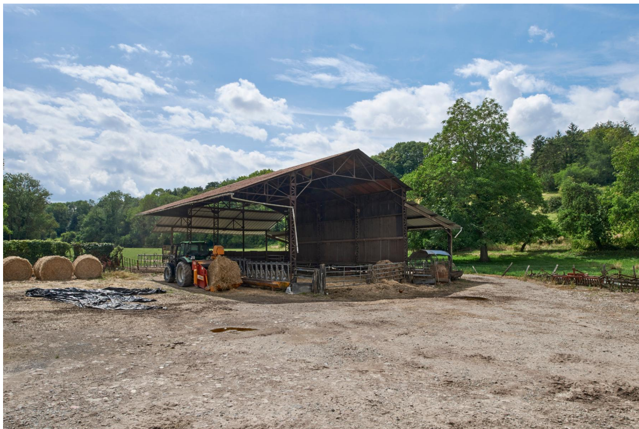
Hangar agricole, vue prise depuis le nord.
