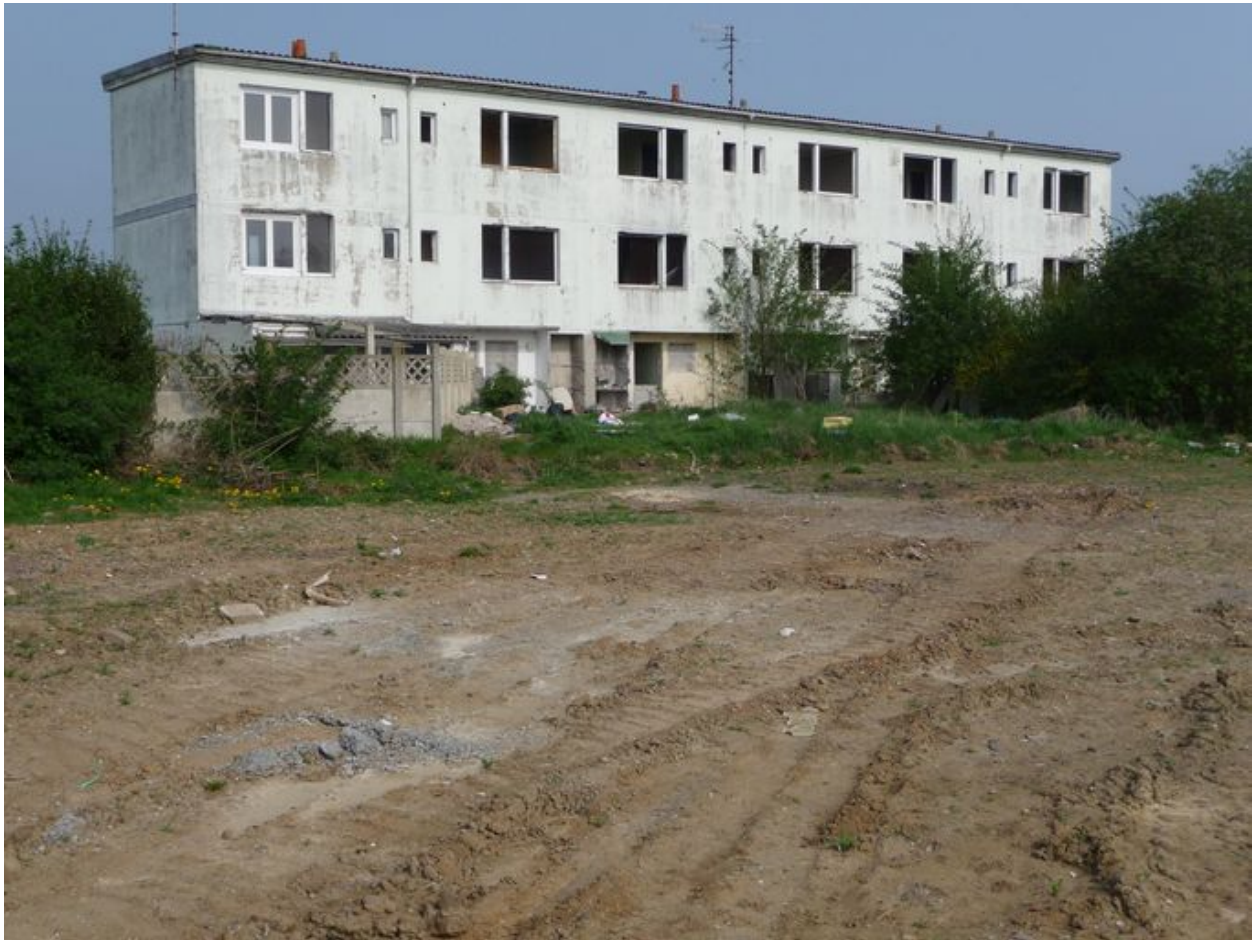
Vue générale d'un groupe de six logements.
