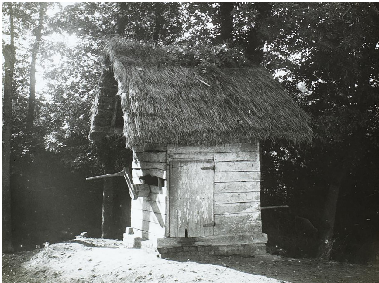
Puits à Vauchelles-les-Quesnoy. Photographie de Camille Biendiné, octobre 1908 (AD Somme ; 35 FI 730).
