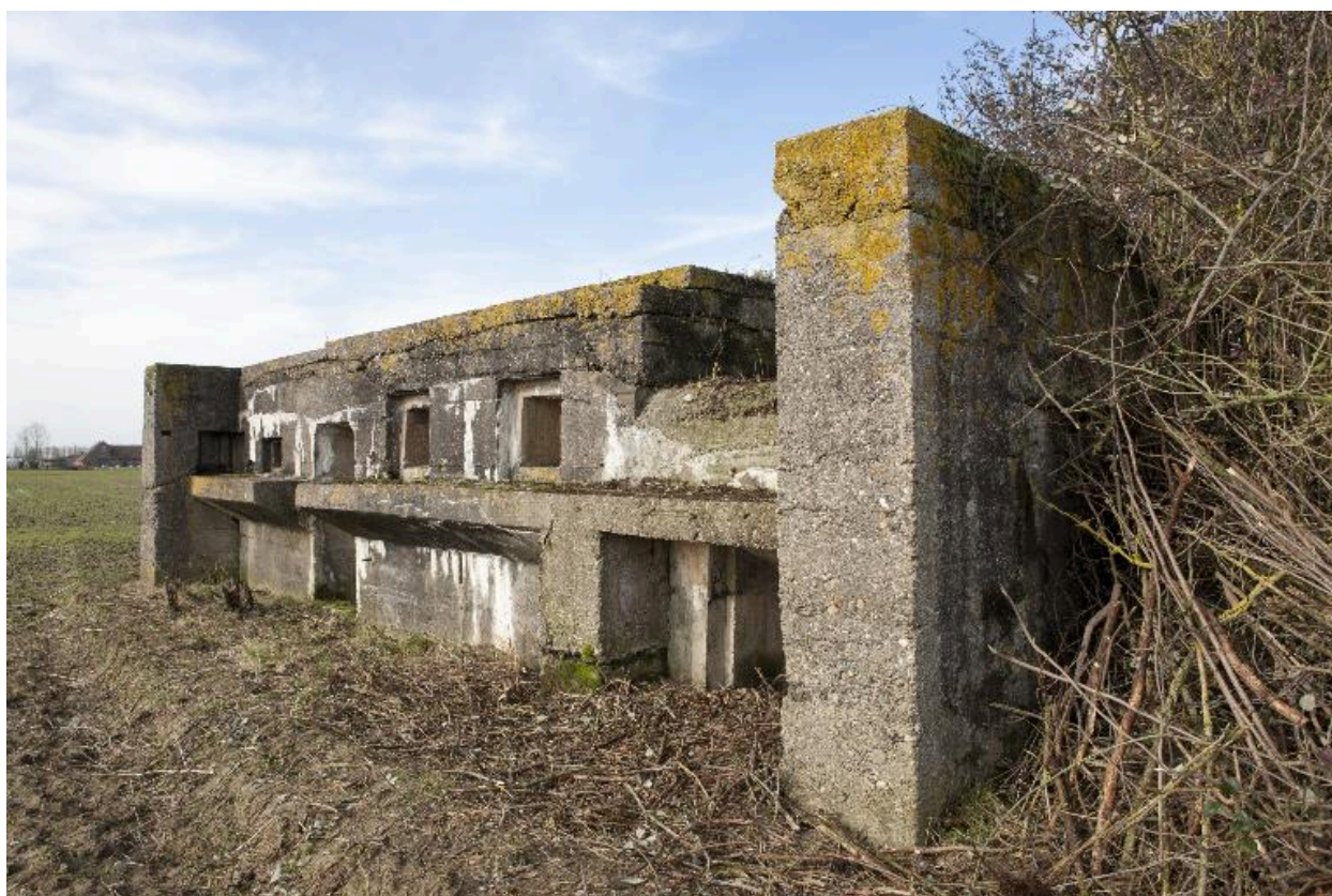
Vue de trois-quarts vers le nord-est
