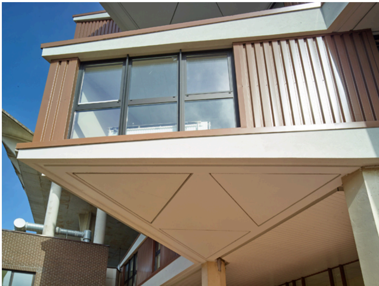
Vue des modénatures en creux des sous-faces des pointes de la tour de l'internat.
