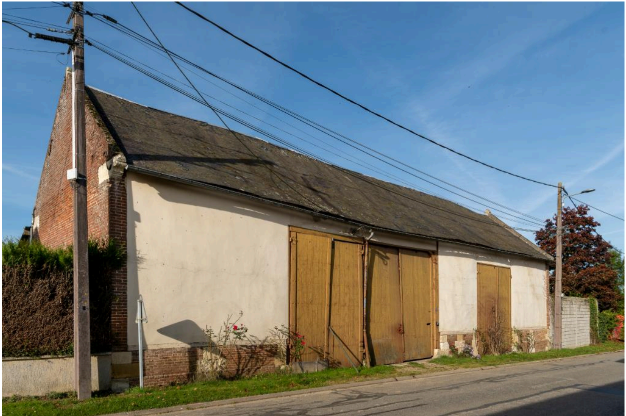
Grange et entrée charretière, n°63 rue Principale, vue depuis le sud-est.
