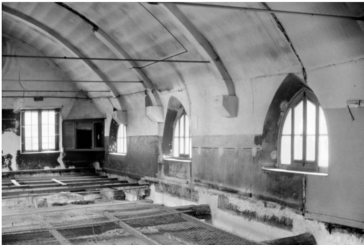
Vue de la chapelle : charpente.
