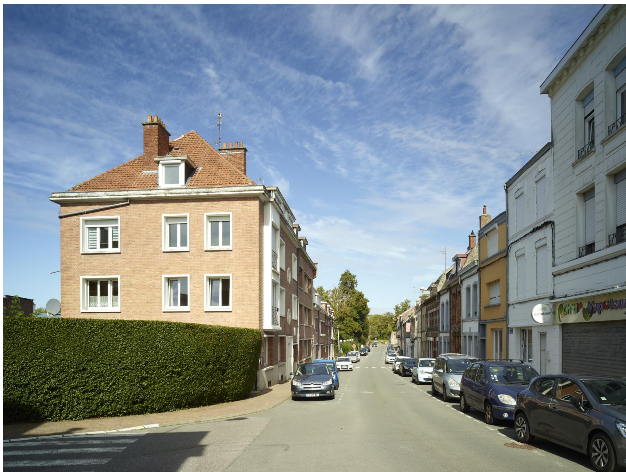
Vue de la rue Tanis orientée sud/nord : exemple d'insertion des immeubles Seconde Reconstruction (situés sur la gauche de la photo) dans le gabarit du bâti préexistant.
