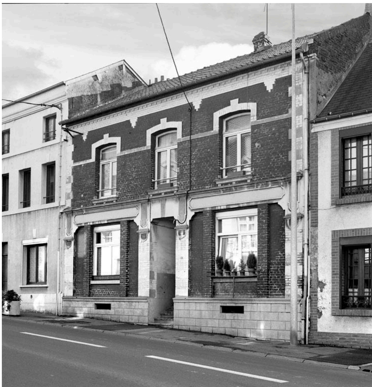
Vue de la façade sur rue.
