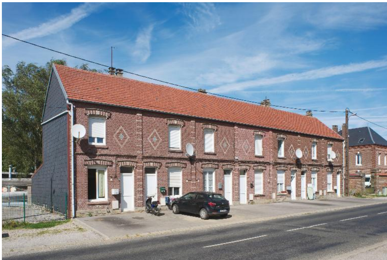
Vue générale depuis la rue du Chevalier-de-la-Barre
