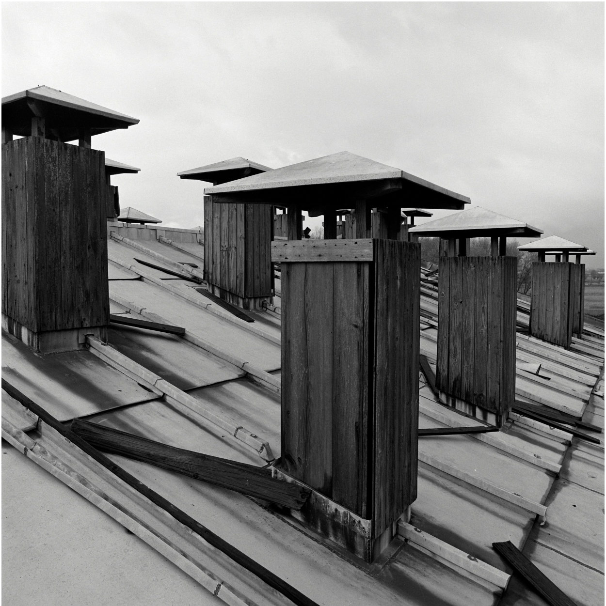
Pièce de séchage dite séchoir au feu (D). Détail des cheminées.
