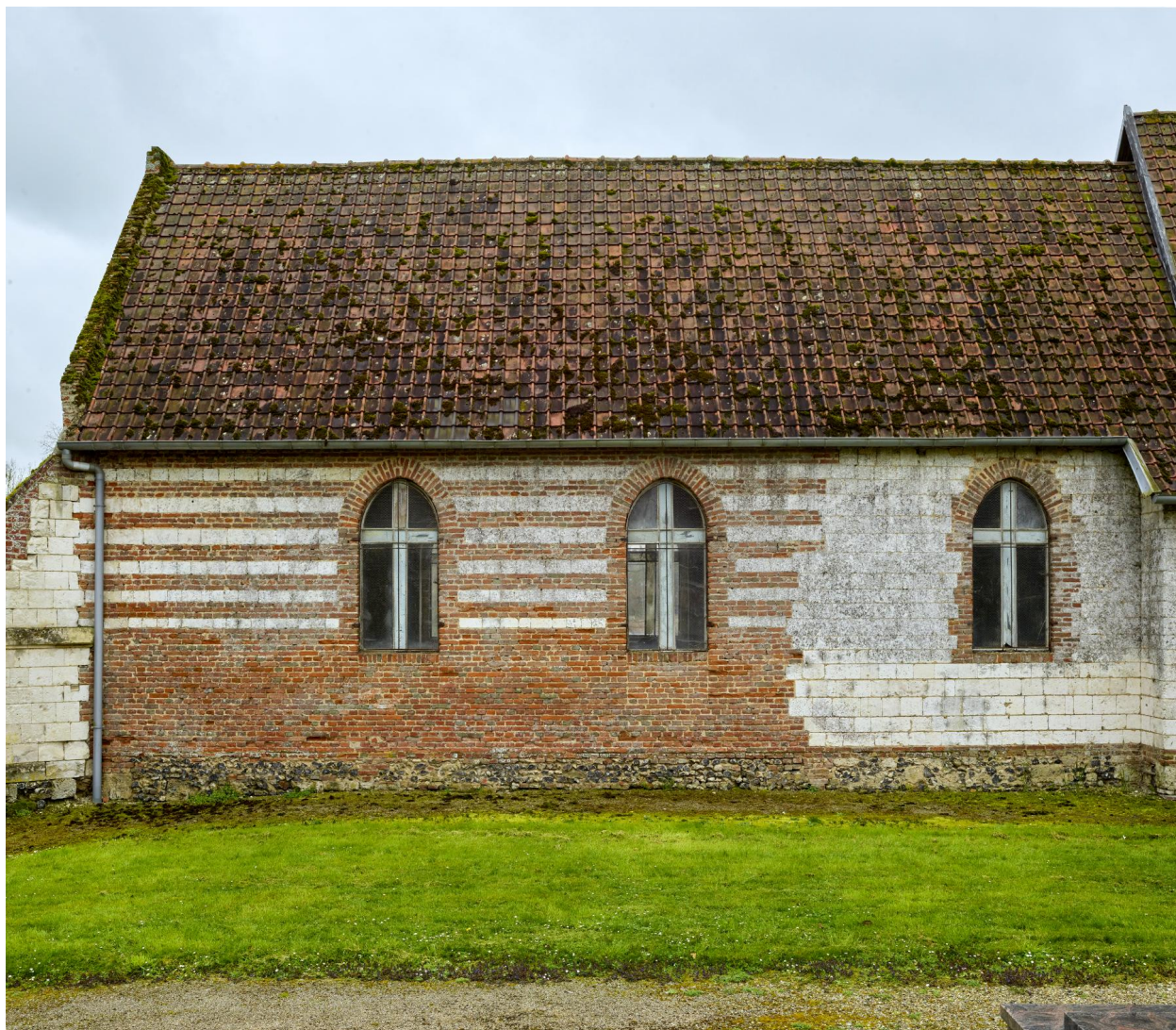
Détail des travées du chœur, élévation nord.
