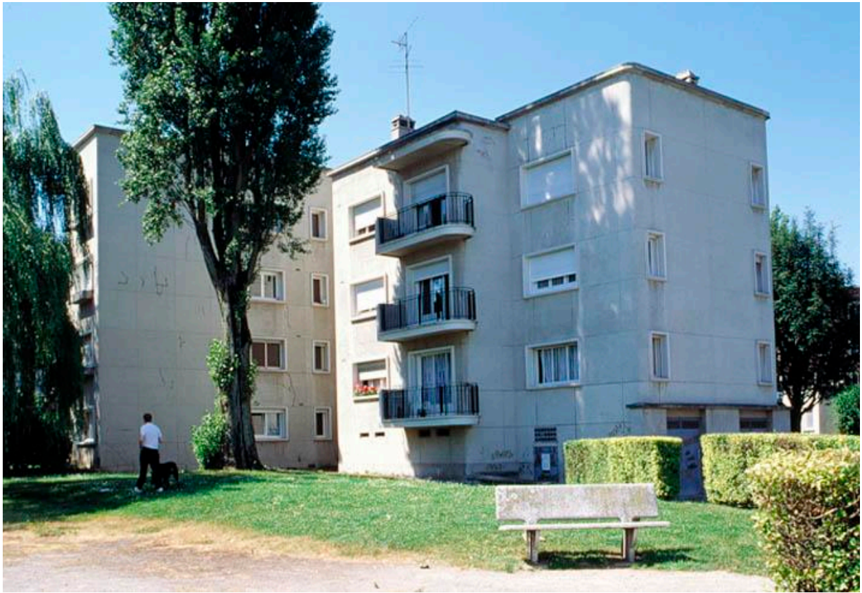
Élévation postérieure d'un immeuble.
