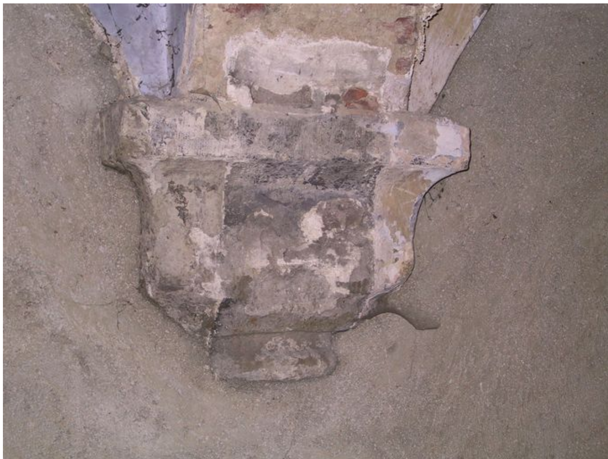
Intérieur, rez-de-chaussée, salle conventuelle : chapiteau, état en 2005.
