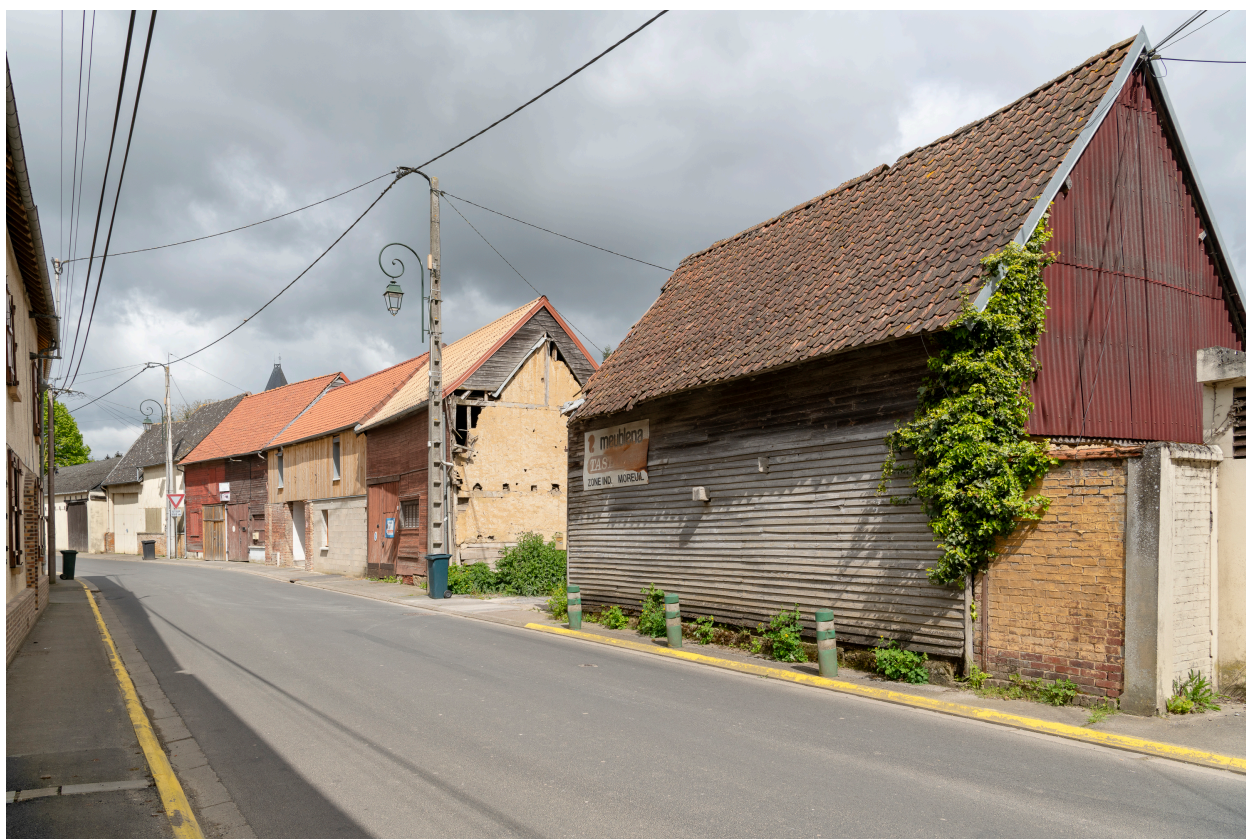
Vue générale de la rue Lambin depuis le sud.
